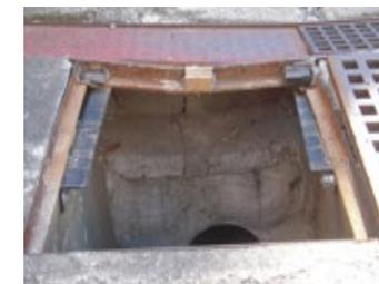
枠の損傷（蓋の浮きの原因）
