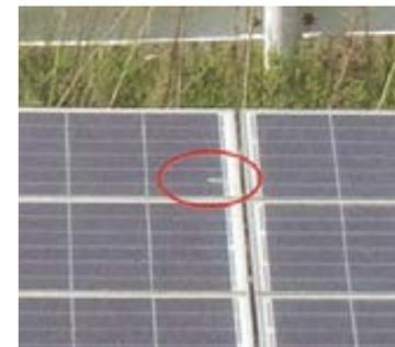
太陽光パネルの損傷<sup>9</sup>
