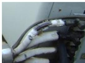
配管断熱材の剥れ
