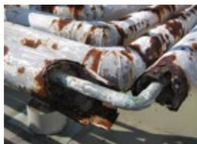
配管断熱材の損傷
