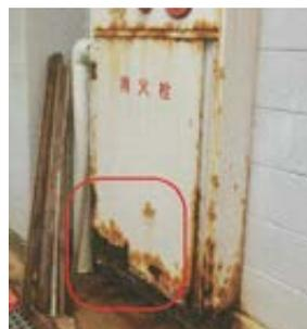
消火栓箱の損傷<sup>◆10</sup>
