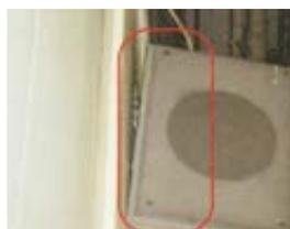
拡声装置の取付不良<sup>◆3</sup>
