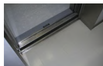
エレベーター扉の敷居溝
