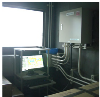
パワーコンディショナー ※換気口は盤側面等
