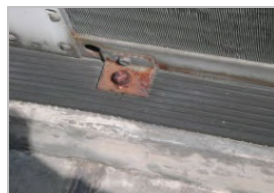
室外機金属部分
