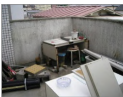
屋上に置かれている不用品
